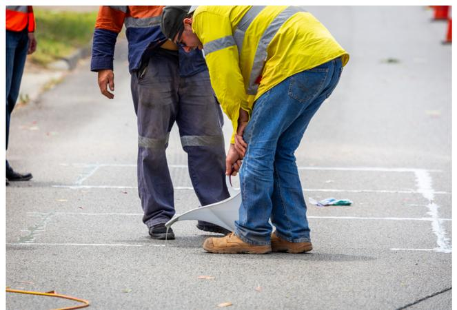
L'installazione delle spire induttive è semplice. Hai già delle spire installate? Collega facilmente il RoadPod VL.
