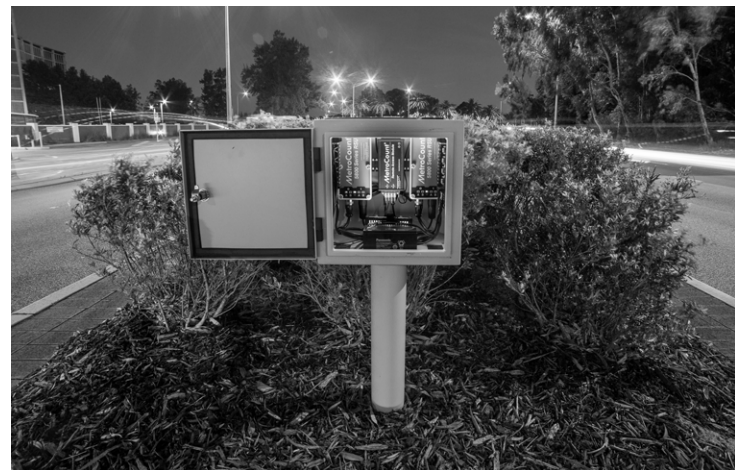
Teller, schakelbord en 3G-modem in kast.
