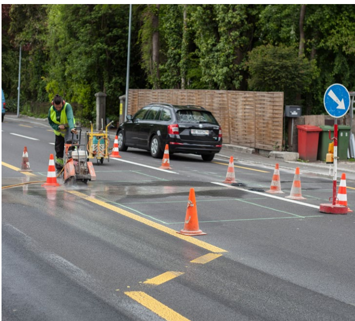
Installatie van lussen volgens MetroCount specificaties.
